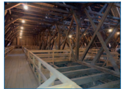
Das tolle Dachgebälk
