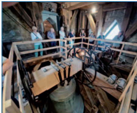
2019 erneuert: Der Glockenstuhl
